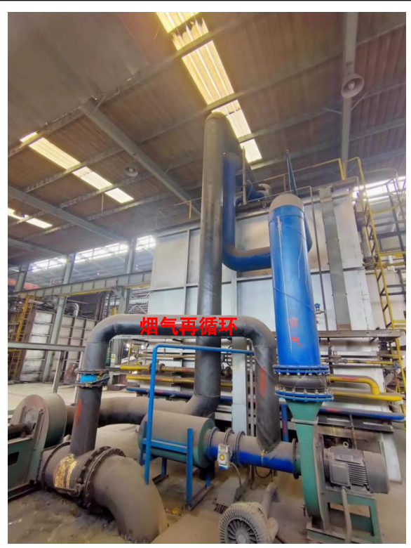
3#50t 天然气加热炉低氮燃烧装置 (低氮燃烧器+烟气再循环)
