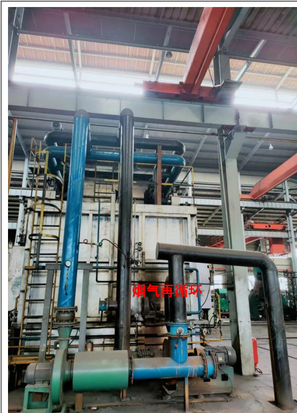
4#20t 天然气加热炉低氮燃烧装置 (低氮燃烧器+烟气再循环)
