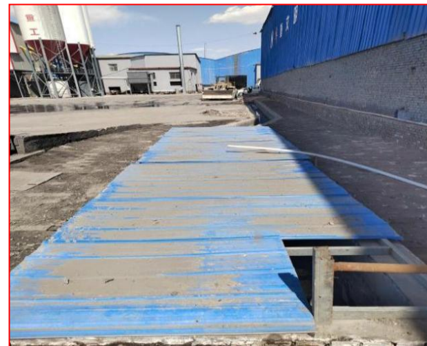
厂区现有初期雨水收集池
