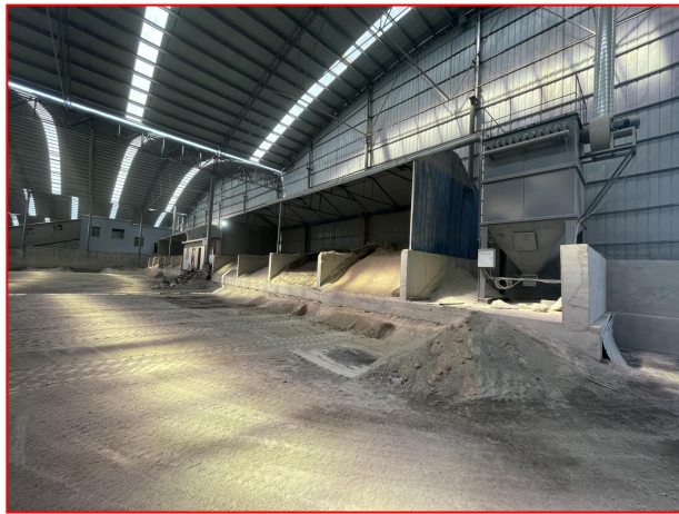
现有商品混凝土生产线原料库进料仓
