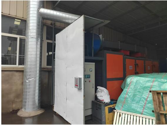
吹膜、印刷废气处理设施
