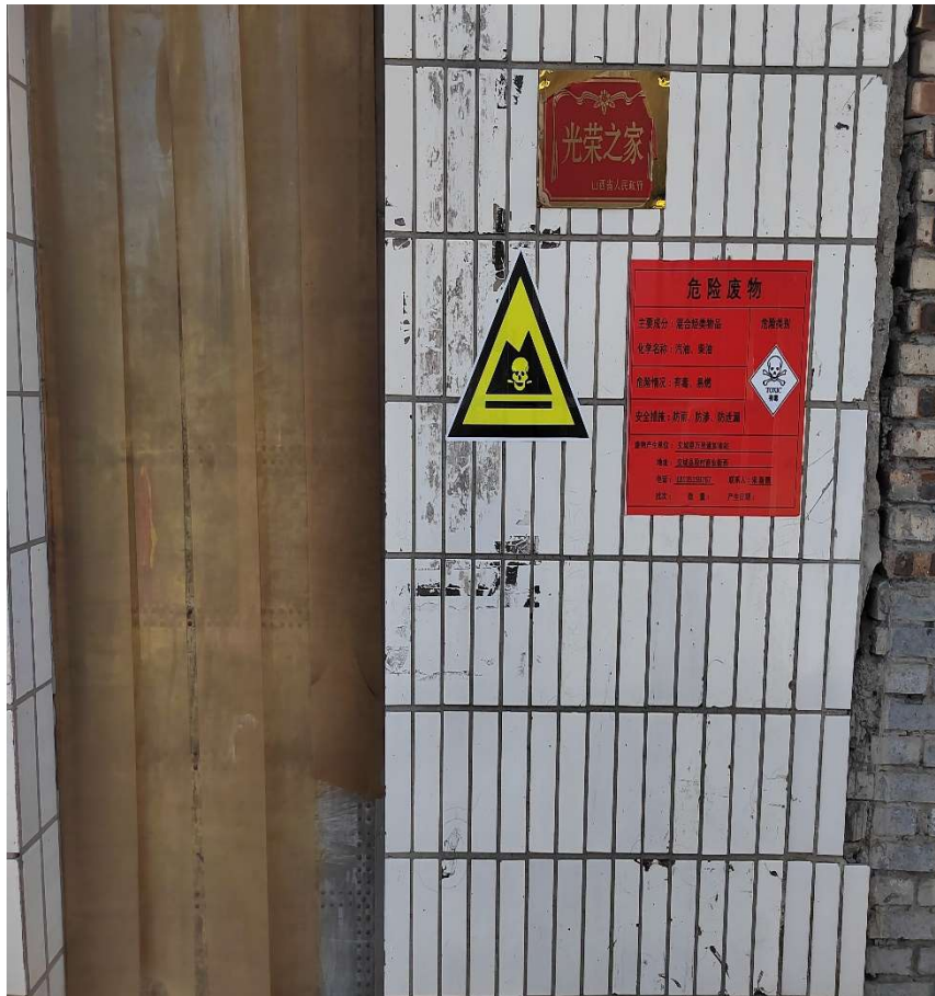
项目建成的危废间
