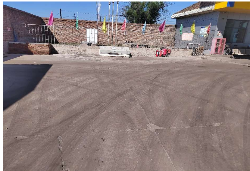
加油区卸装区
