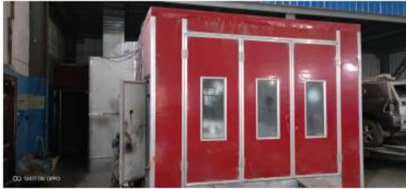
全封闭烤漆房及车辆出入口
